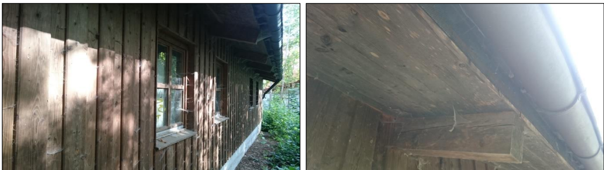
Abb. 3 u. 4 Schuppen mit Holzfassade und mit Gitter verschlossenes Vordach
