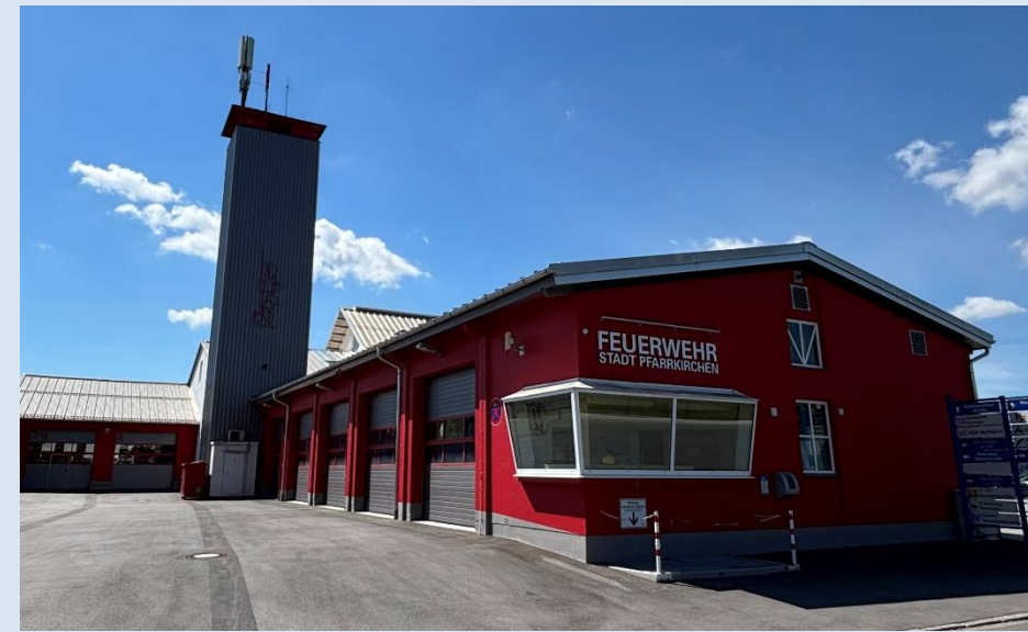
Sanierung Feuerwehrhaus Pfarrkirchen
