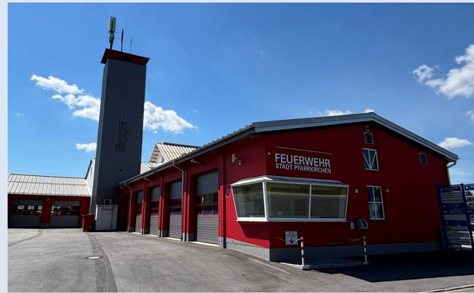
Sanierung Feuerwehrhaus Pfarrkirchen
